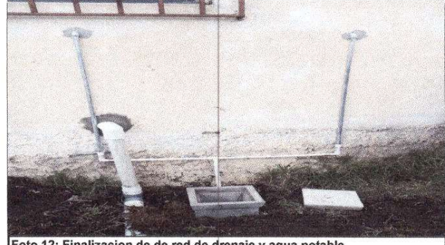
Foto 12: Finalización de red de drenaje y agua potable.
