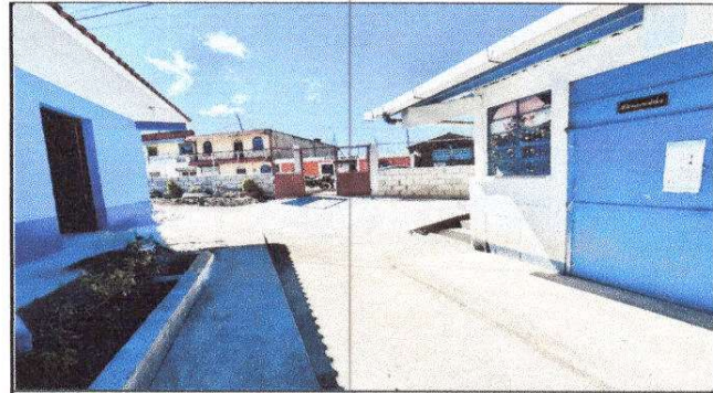
Foto 10: Finalización de piso de concreto frente a las aulas.
