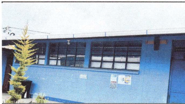
Foto 7: Finalización de canales y bajadas de agua de aulas.
